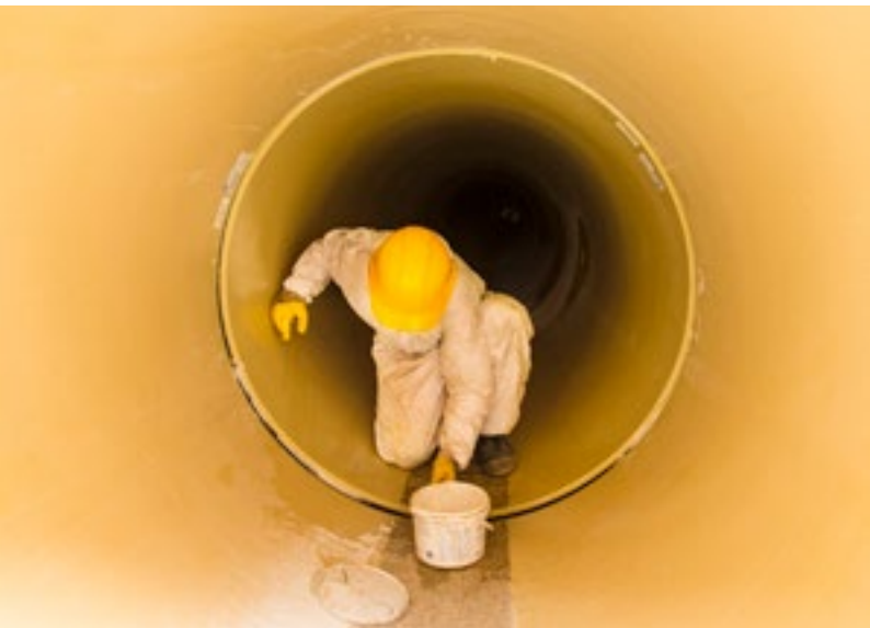
Aufbringen eines Gleitmittels zur Minimierung der Einschubkräfte
