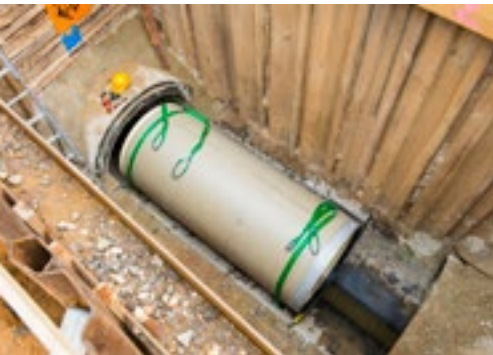
Einbringen eines Kurzrohrs über einen Montageschacht
